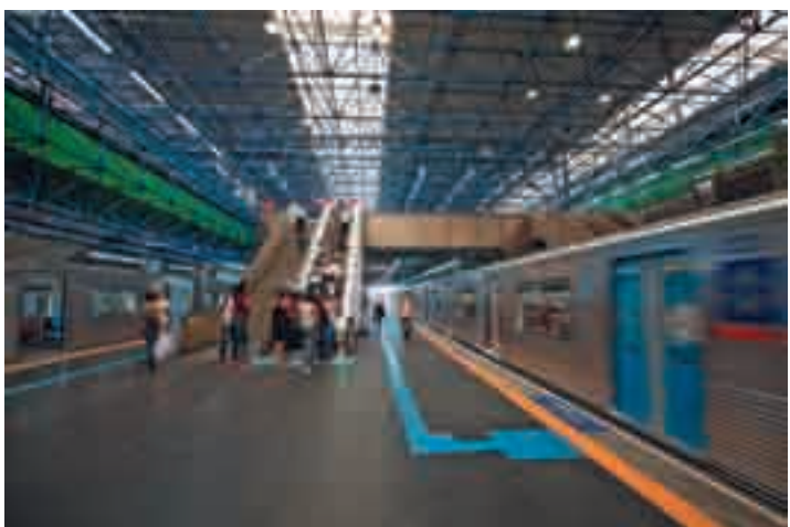
Plataforma de embarque e desembarque da estação Barra Funda do metrô, em São Paulo, SP, 2012.
