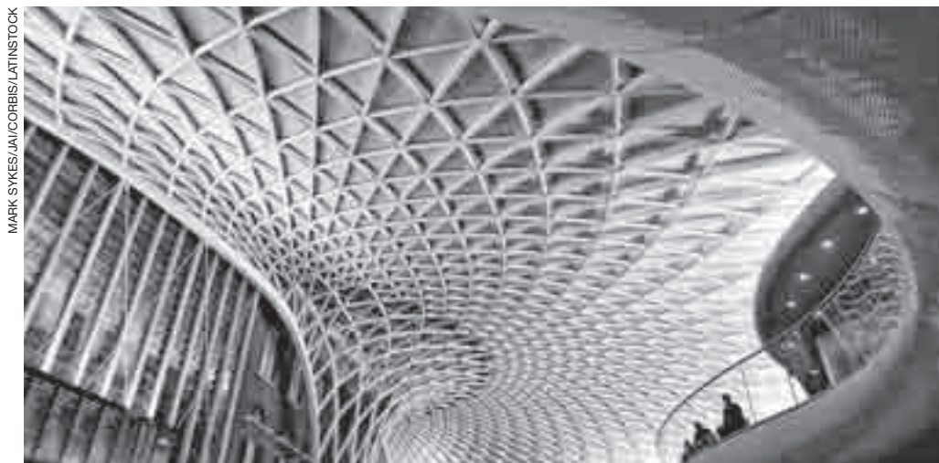
A estrutura de uma cobertura precisa ser rígida. Na foto: cobertura de estação de trem em Londres, Inglaterra, 2012.
