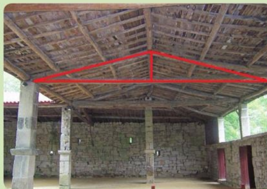
Estrutura de telhado com tesouras
